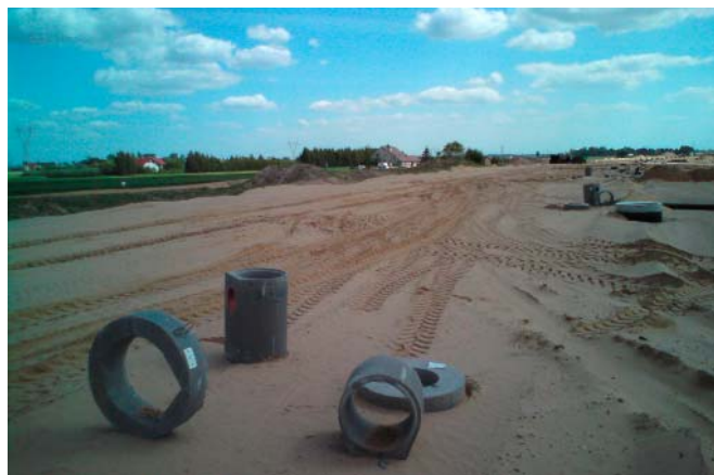
Fot. 1. | Tu na razie jest ściernisko
